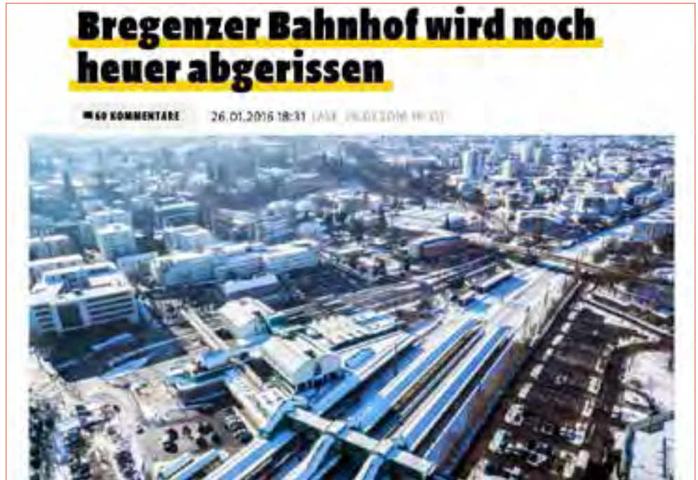
Schon anno 2016 wurde verkündet: Heuer wird der Bahnhof abgerissen.
